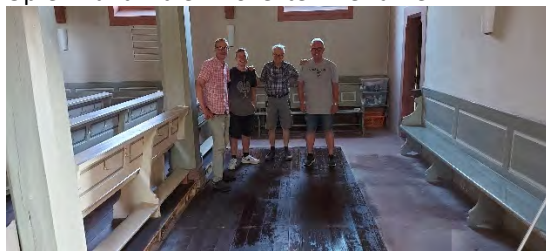
Bänke und Bankpodeste wurden entfernt
